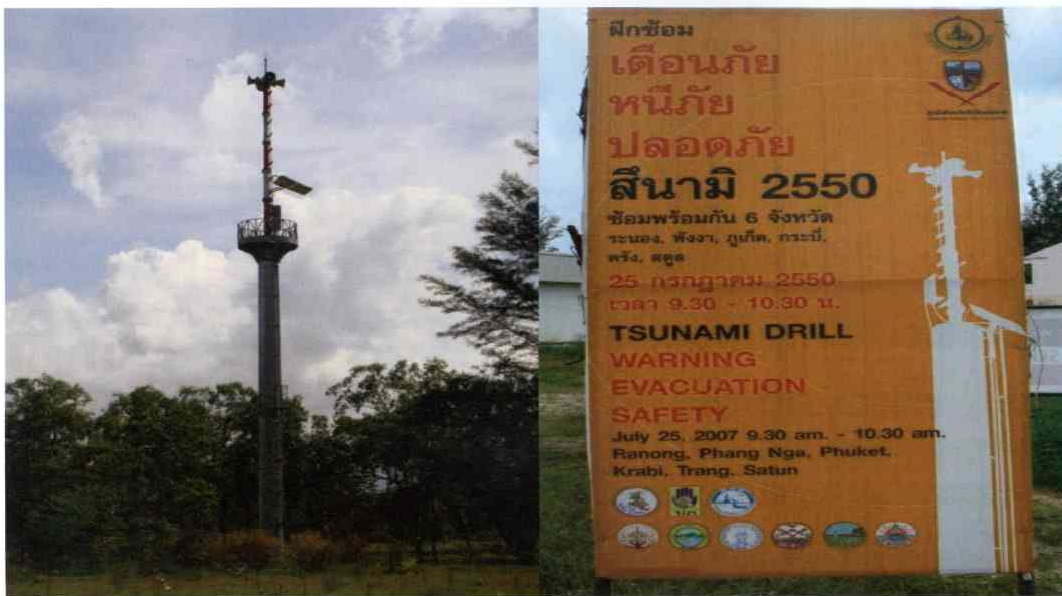
写真3 津波警報タワー（左） 沖合のブイの津波情報を受けて、自動で避難を呼びかけるシステム。右はこのタワーの説明と津波避難を呼びかけるサイン
