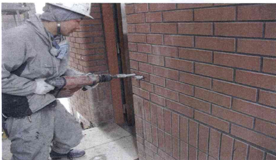
アンカーボルト設置
