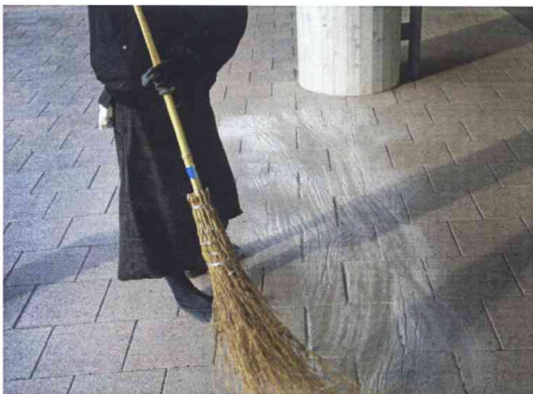
目地砂施工状況
