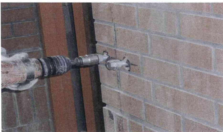
アンカーボルト設置
