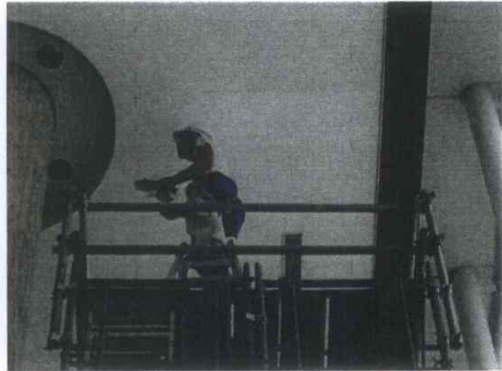
天井岩綿吸音板破損部復旧
