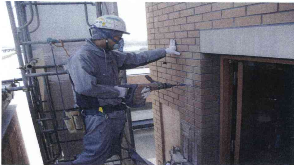
アンカーボルト設置
