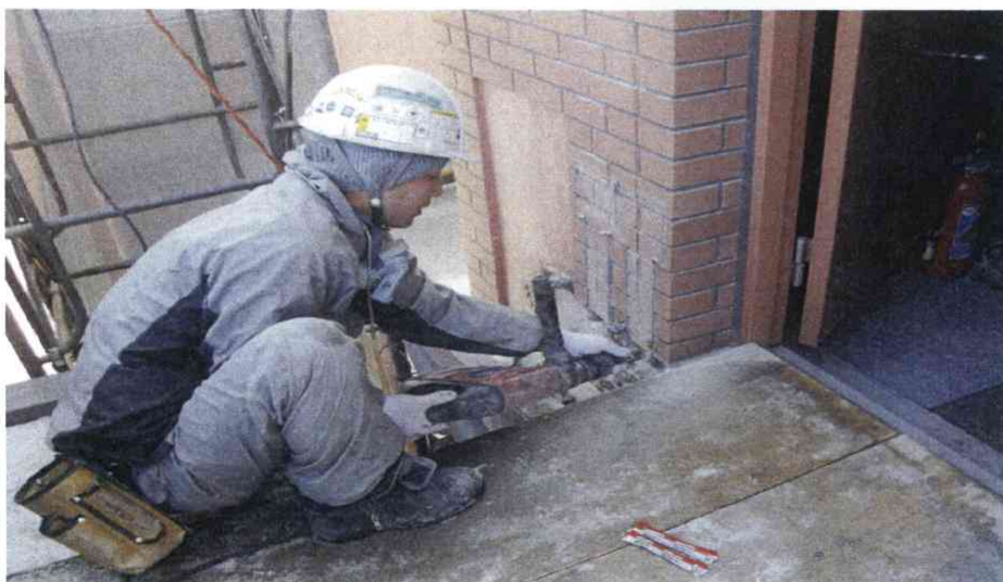
アンカーボルト設置
