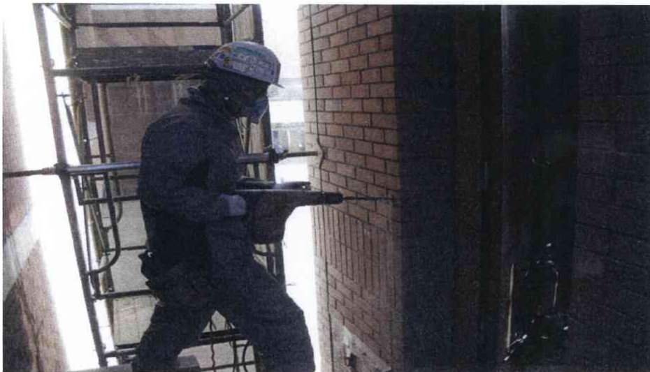
アンカーボルト設置
