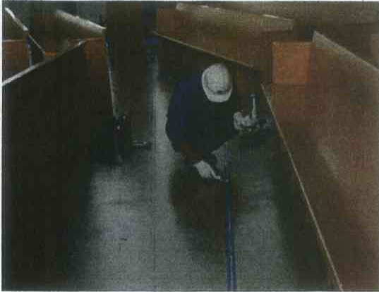
床クラック長尺シート補修状況
