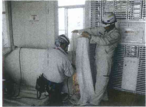
防火戸下部切断作業状況
