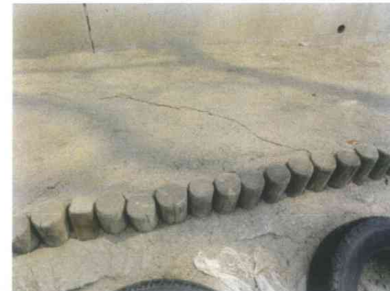
幼稚園 園堤の東屋の下、階段上部の地盤が 地割れ状態
