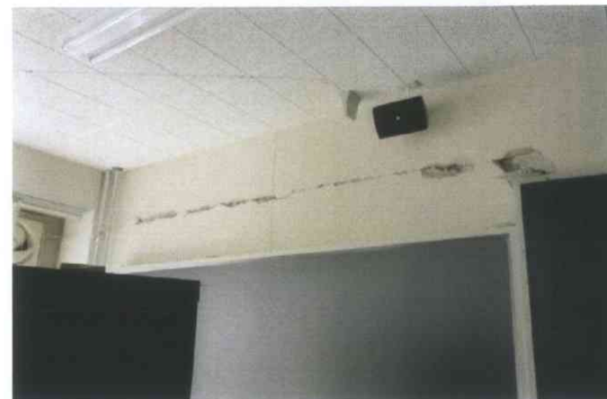
教室の壁に亀裂、仕上げモルタル落下
