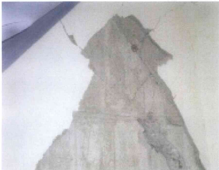
講義棟 外部壁内部崩落
