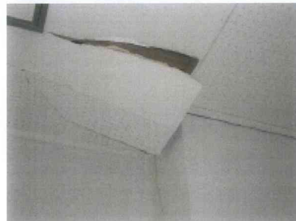
教室 仕上げモルタル剥落
