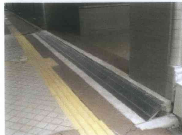
25センチ程度沈下により傾斜
