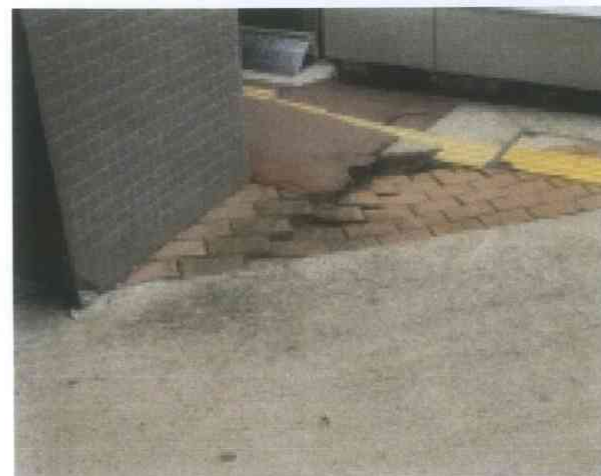
30ミリ程度の地割れ、20センチ程度沈下
