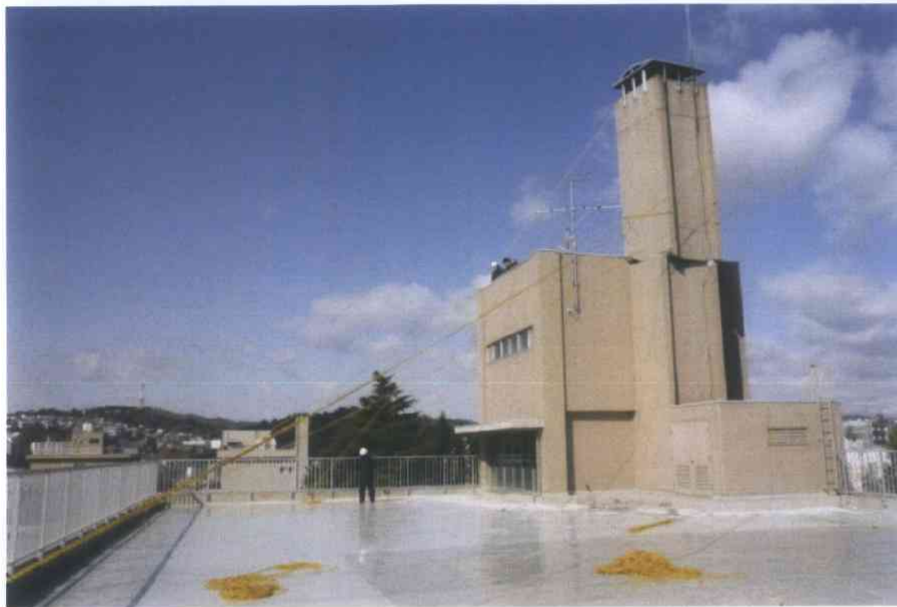
7号館の煙突 倒壊の危険
