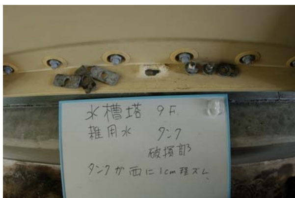
図2.4 架台のズレ、固定ボルトの破断・抜け
