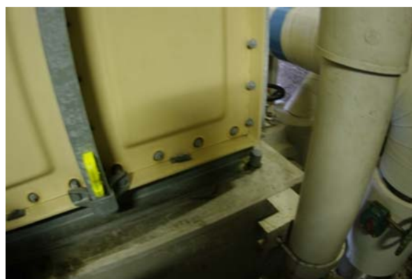
図2.5 架台アンカーボルトの曲がり
