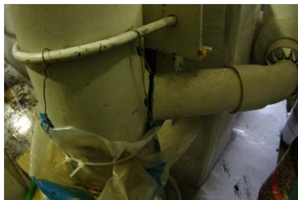
図2.6 ブロー管接続部の損傷
