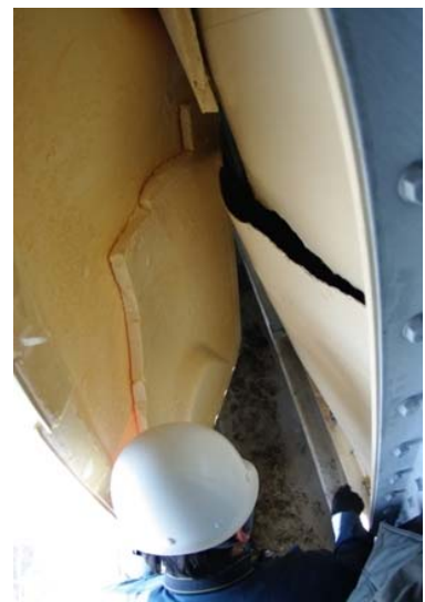
図2.3 水槽パネル破断部分
