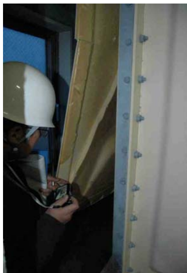
図2.2 水槽パネル剥離部分
