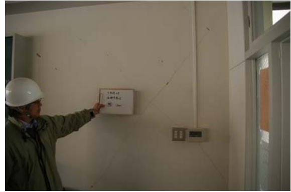
写真 5.8 7号館3F法律学専攻教室：西側内壁のほか、短軸方向に配された耐震壁に0.3mmを超えるせん断ひび割れが多数発生している。
