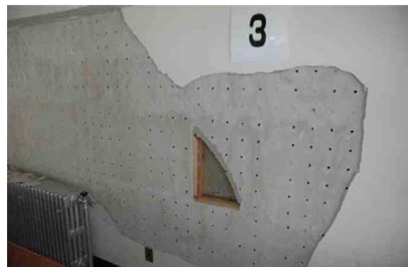
写真 3.5 4化粧仕上げ材が剥落
