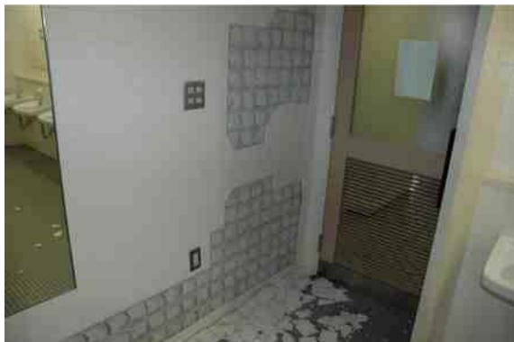
写真 4.1 トイレのタイルの剥離
