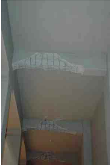
写真 4.7 はり部材の破壊。はりの鉄筋が露出し、内部のコンクリートが砕かれた状況、余震によりコンクリート片の落下の可能性あり
