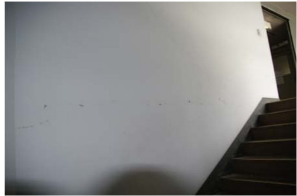
写真 3.9 6号館1F 階段部：階段部とスラブの境目に幅0.5mm 程度の水平のひび割れが生じている。
