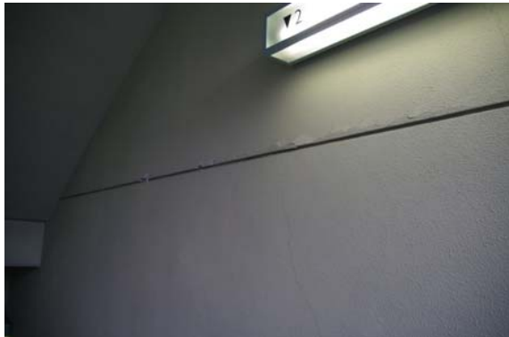
写真 4.2 3号館階段部：中央階段部分に貫通したせん断ひび割れが発生している。
