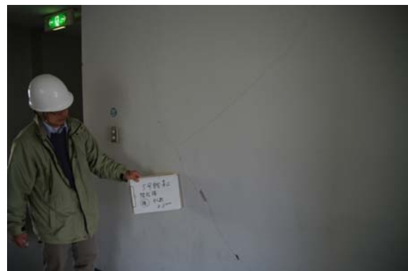
写真 5.3 5号館4F：西側廊下と講義室との間の耐震壁に0.1～0.2mm程度のせん断ひび割れが発生している。
