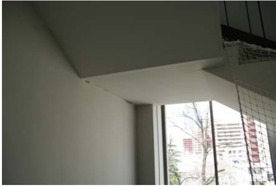
写真 5.7 7号館3F階段：ひび割れがあり、通行によってコンクリート小片が剥離する可能性がある。
