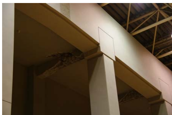
写真 4.5 体育館アリーナ下面：アリーナを構成している RC 基壇部分の一部のはりが大破している。
