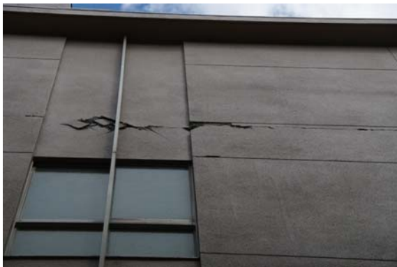
写真 5.9 7号館外壁：4階と5階の間の外壁部分にひび割れが発生し、外装材が剥離して落下する可能性がある。早期に補修の必要あり。
