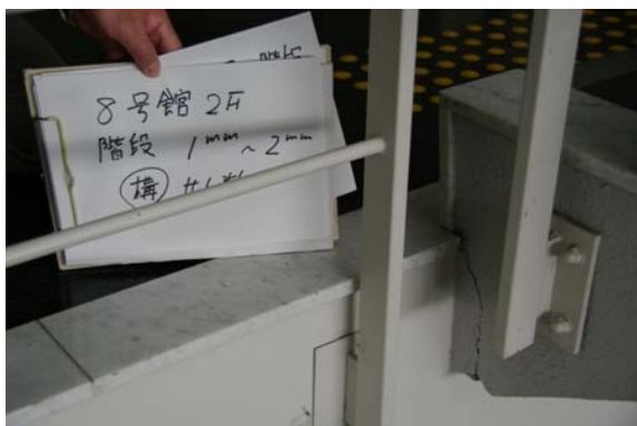
写真 5.10 8号館 2F階段：中央階段部分下部に0.2mm 程度の貫通したひび割れがあるため、補修の必要あり。
