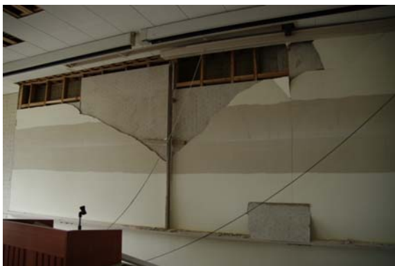
写真 3.4 4号館4F 442教室：黒板側の壁に施されたモルタルによる化粧仕上げ材が過半の部分で剥落し、下地の木材が露出している。
