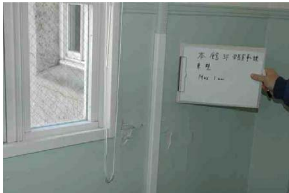
写真 5.1 学長室事務課に発生した最大1mmのひび割れ
