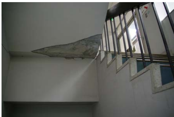
写真 5.2 5号館地下階段：階段の裏面に損傷があり、コンクリートが剥落する可能性がある。
