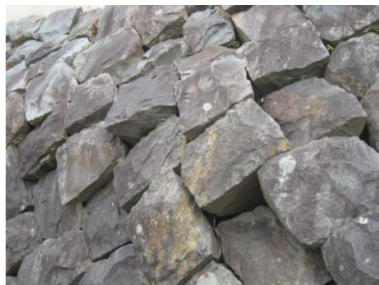
写真 3.12 南北方向の石積みの緩みの状況。南より北に向かって、石積み高さが低くなっていることも、南北方向のみに石積みの緩みが見られることに影響を与えていることも考えられるが、適切に解釈することは不可能。
