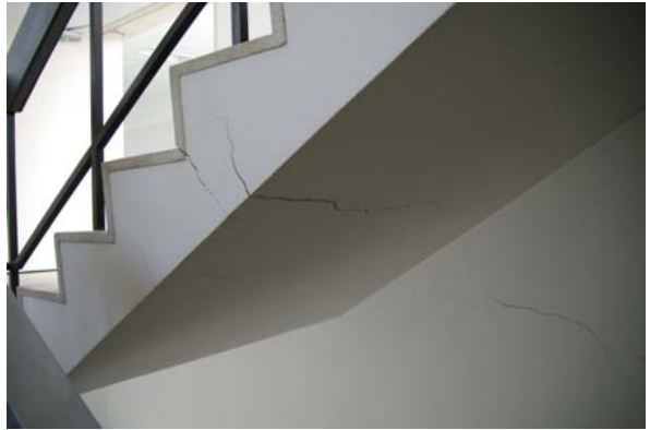
写真 3.3 3号館3F：階段下面のひび割れ。ひび割れ幅が2mm以上あり、通行には危険な状態にある。
