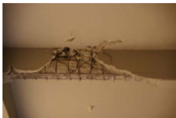
写真 4.6 体育館アリーナ下面：大破したはり（鉄筋内部のコンクリートが粉々に近い状態）。
