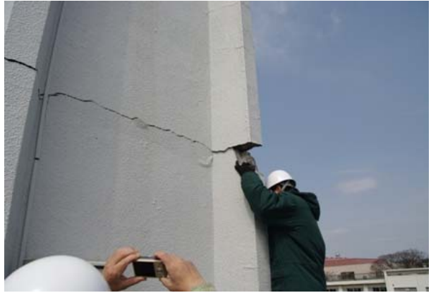
写真 3.7 4号館屋上：煙突の中間部に1mm 以上のひび割れがあり，そこを境に最大15mm 程度ズレが発生している。
