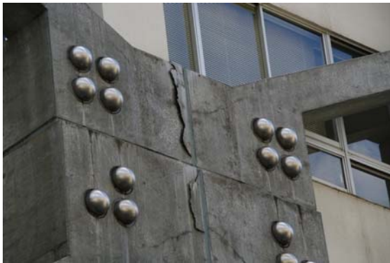
写真 5.6 5号館耐震補強はり：表層部のコンクリートの浮いており剥落の可能性あり。
