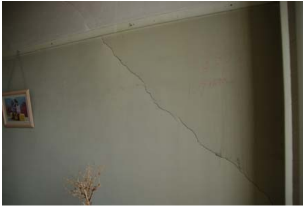
写真 3.2 3号館3F 3302：ひび割れ幅1.7mmのせん断ひび割れ
