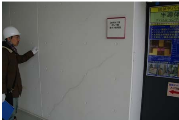
写真 3.1 2号館1F：建物中央の吹き抜けに面した壁面において、柱と柱の間にある非耐力壁に対角を結ぶX状に0.1～0.2mm程度のせん断ひび割れ。各階に同様のひび割れが発生している。
