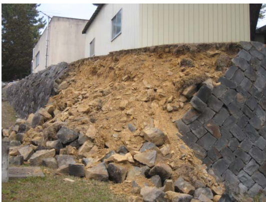
写真 3.11 石積み擁壁の崩壊状況
