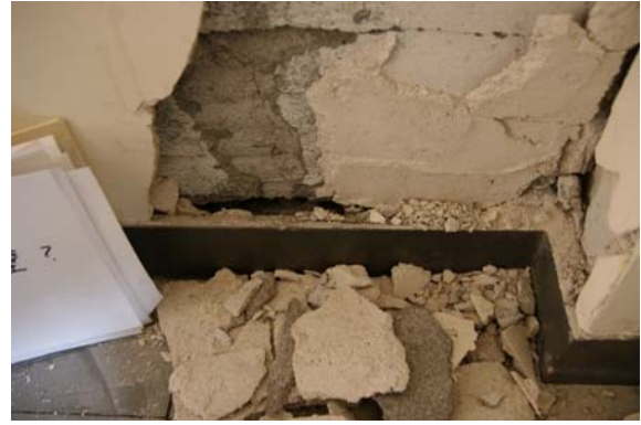
写真 5.5 5号館5F 541教室：間仕切り壁の破損、下部に空洞が見える
