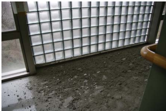
写真 4.4 3号館6F 中央階段踊り場：ガラスブロックの目地モルタルがほとんど剥落、またガラスブロック面が外側に大きく膨れて変形している。建物外側にもガラスブロックが落下する可能性あり。
