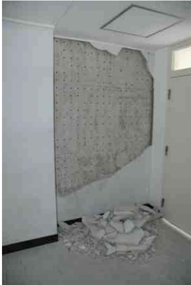
写真 3.6 化粧仕上げ材が剥落
