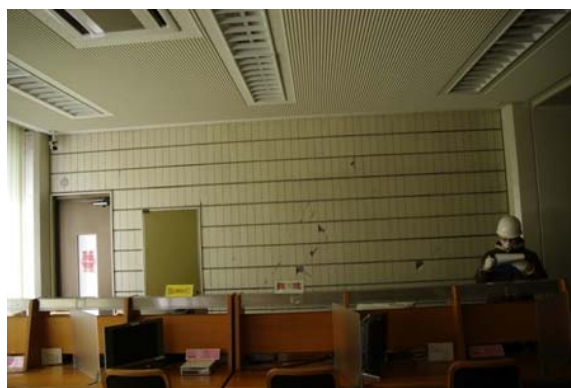
写真 5.16 図書館 1 F：間仕切り壁のせん断ひび割れ
