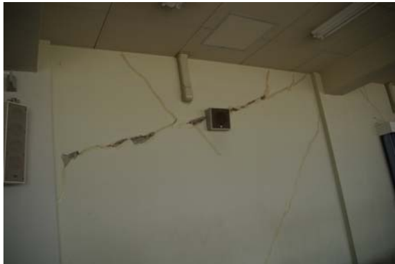
写真 3.8 5号館1F 511教室：廊下との間仕切り壁上部にせん断ひび割れがあり，表面部がV字に剥落している。
