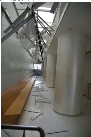
写真 5.12 8号館5F 押川記念ホール：ラウンジ部分のアルミ製化粧ルーバー材が破損し落下している。
