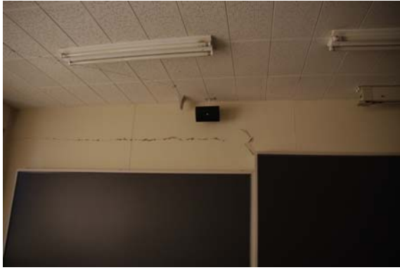
写真 5.4 5号館541教室：壁に施されたモルタルによる化粧仕上げ材が一部で浮き、剥落のおそれがある。
