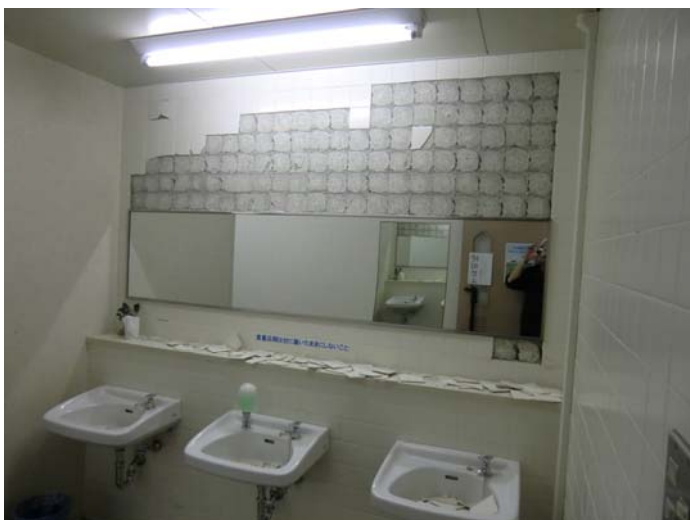
1-D 写真 No.0228 トイレ ※館内のトイレタイルの剥離は著しい
