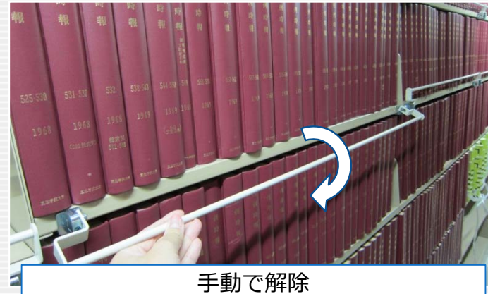
書架の上段2-3段目に落下防止バーを設置
