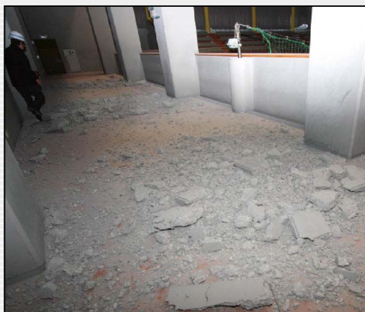
体育館は地盤が激しく揺れたため、天井部の建材が落下
