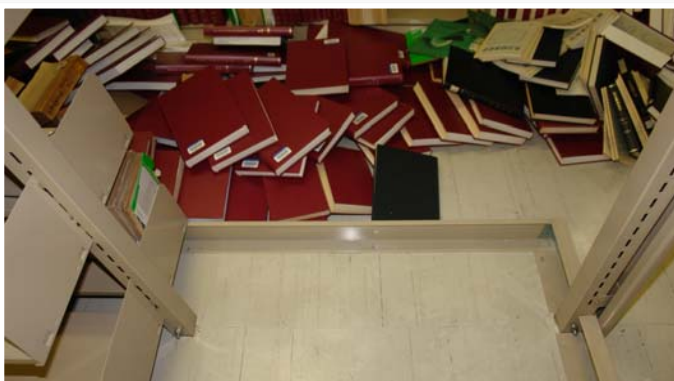
歪みのひどい書架を一部解体 (背面に筋交を入れたのち、再度組み直す)
