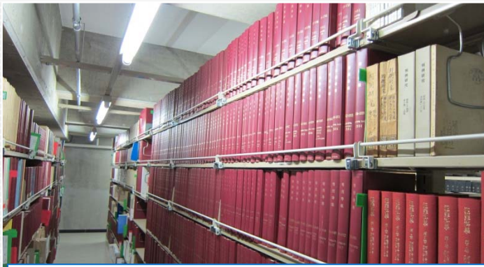
書架の上段2-3段目に落下防止バーを設置
