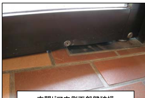
玄関ドア内側下部鍵破損
