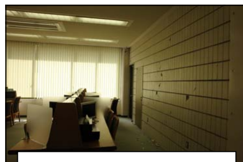
壁面タイルの欠落
