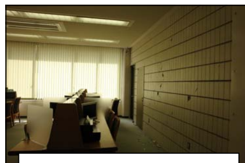
壁面タイルの欠落
