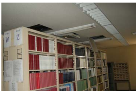
天井点検口蓋が落下および開放、換気扇がずれて落下寸前
