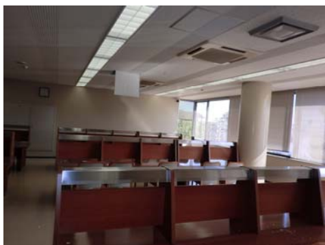
天井の空調のずれと点検口蓋の開放
