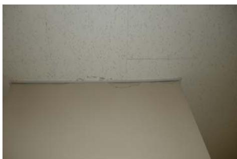
天井近くの壁に亀裂&たわみ
