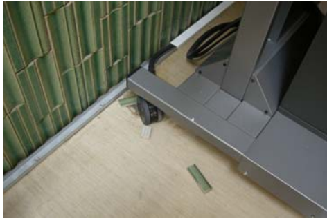
剥離して落下したタイルの破損残骸
