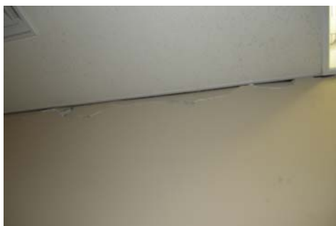
天井近くの壁に亀裂び&たわみ
