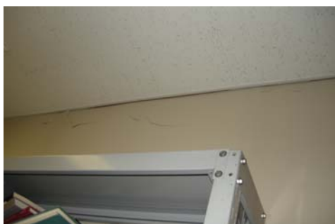
天井近くの壁に亀裂&たわみ
